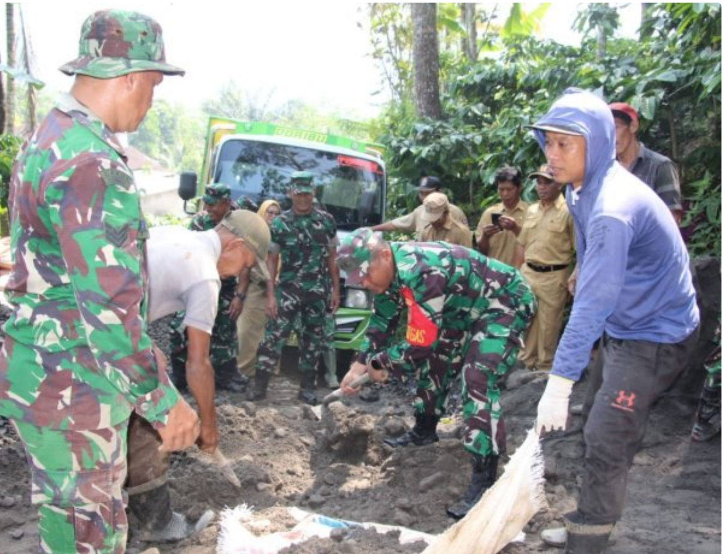
Dandim 0706/Tmg Bersama Anggota Turut Membantu Warga Dalam Poses Pengecoran Jalan
