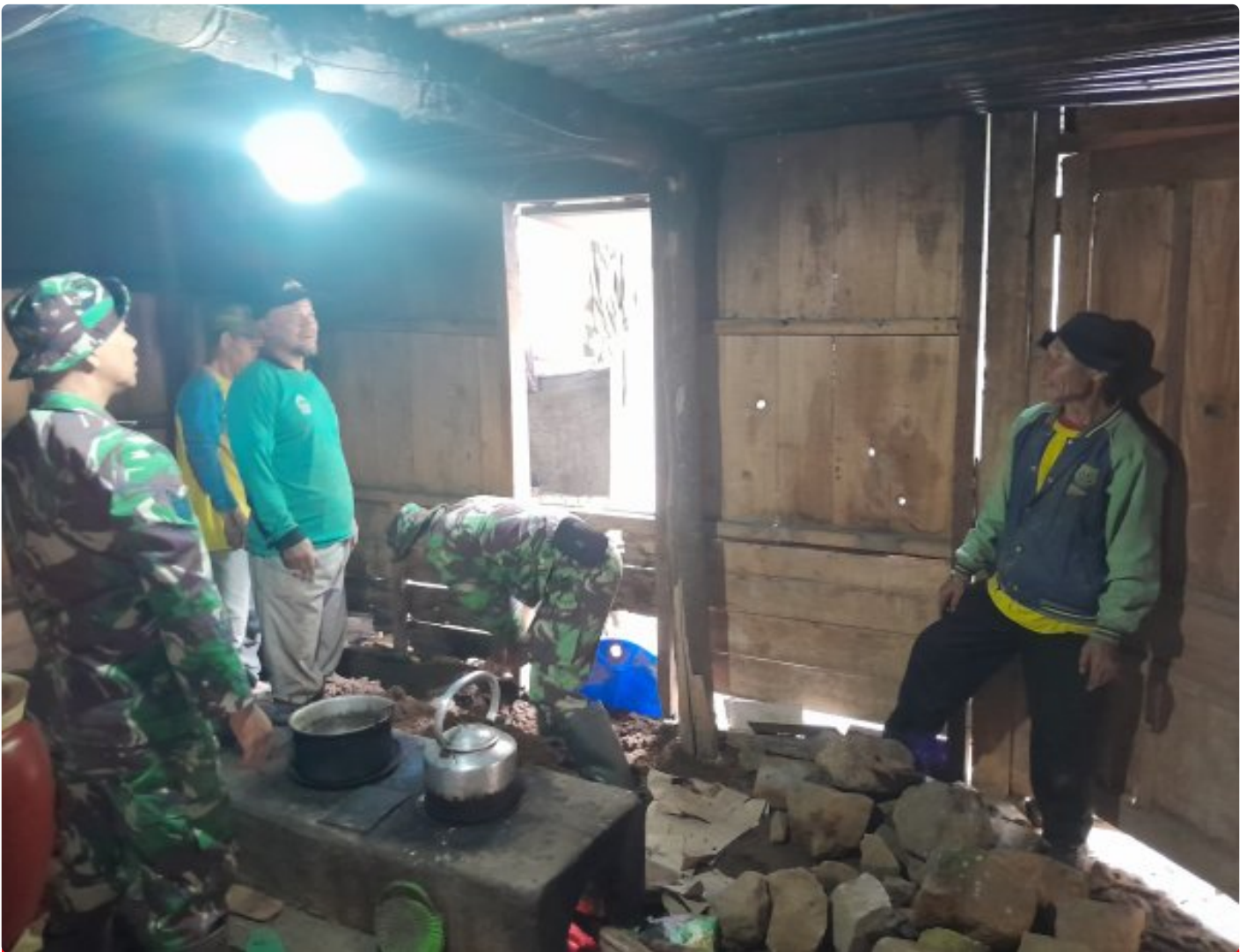
Perbaikan Rumah Bpk Tabroni dikerjakan Secara Gotong Royong Antara Satgas TMMD Dengan Warga
